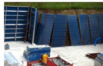
Pose de banches
