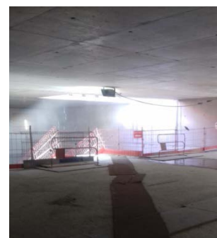
Chantier d'une station du métro
