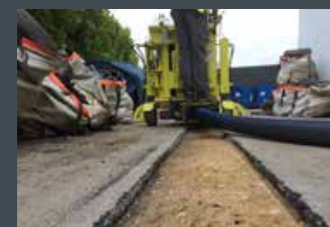
Rabotage d'enrobés avec aspiration à la source
