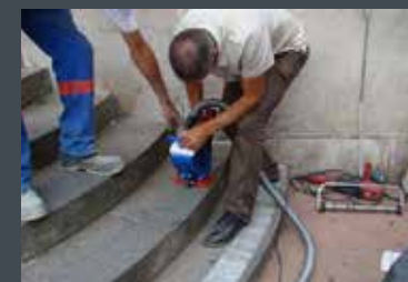
Décapage de surface avec aspiration à la source
