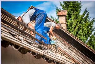
Juillet 2019, le dirigeant d'une entreprise bretonne demande à son chef d'atelier d'aller réparer un élément de toiture dégradé constitué de matériaux fragiles et situé à 5 mètres de hauteur. Le salarié non formé à ce type de travaux et ne disposant d'aucun équipement de protection chute au travers du toit. Le responsable de l'entreprise est par la suite condamné à payer une amende de 30 000 euros et à une interdiction de gérer.
